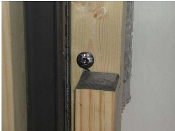
Photo 5.6 : position de la vis de penture
