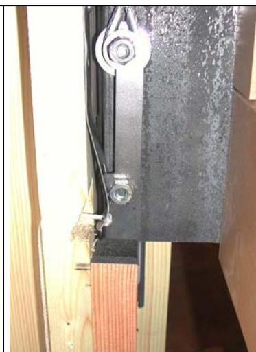
Figure 5.5c : détail ressort et mentonnet.
