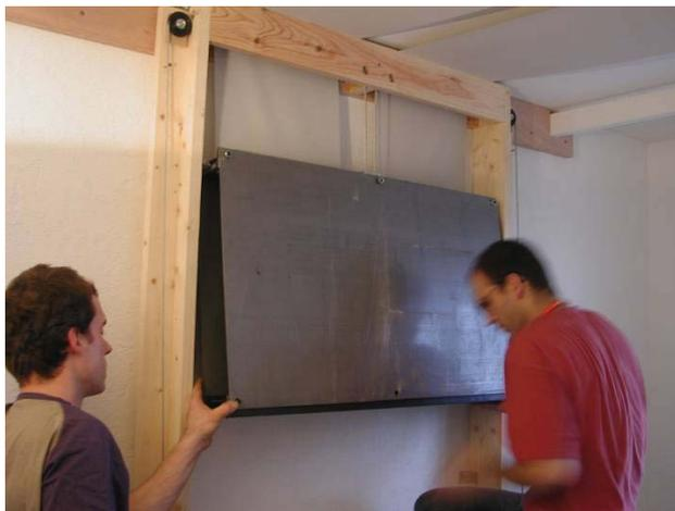
Tout en maintenant le U inférieur contre la tôle coté mur, enlever les 3 écrous du bas et placer la tôle sur le U. Revisser les 3 écrous. Bien serrer les 6 écrous.
