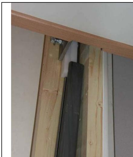
Photo 5.5a : enfilage des rails en C
